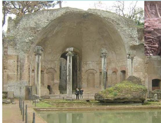
板状のレンガを水平あるいはくさび状に埋め込み、垂直荷重に抵抗するように工夫している。
